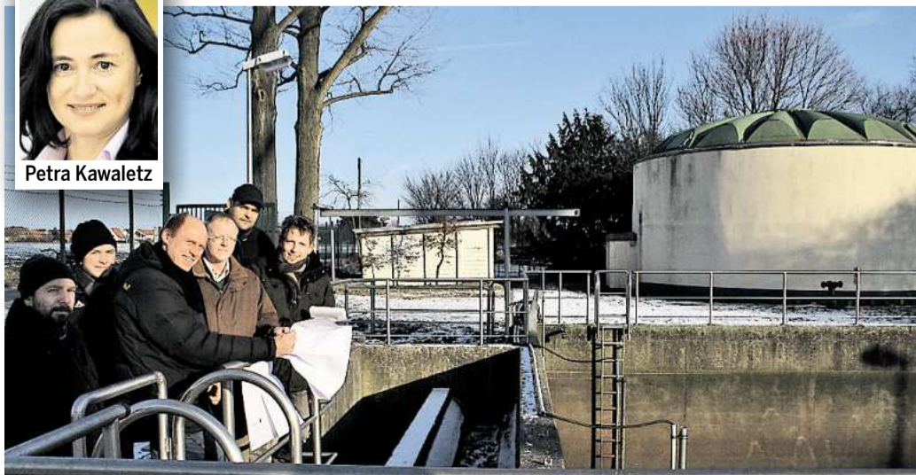
Das Klärwerk in Schmedenstedt: Über Dungenbeck soll nun mithilfe der neuen Abwasserpumpstation das Abwasser aus Schmedenstedt in die Zentralkläranlage nach Telgte gelangen.
